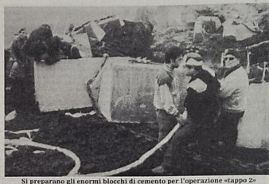
Si preparano gli enormi blocchi di cemento per l'operazione «tappo 2»
